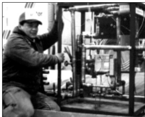
Entretien du chauffage communautaire (District heating)
